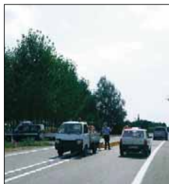
Installate le "barriere" sull'asfalto
