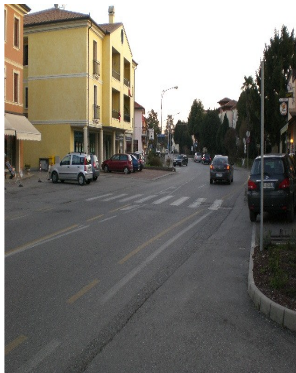
anche il passaggio pedonale seguente è senza segnaletica
