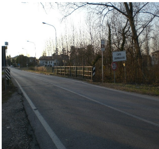
il cartello di preavviso "autovelox" si trova fissato ad un lampione dopo il ponte
