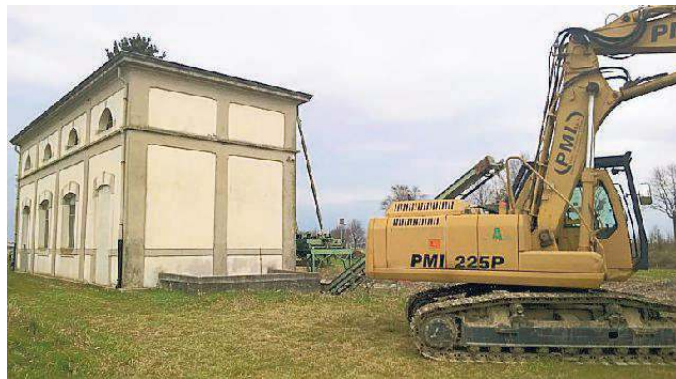
Lavori all'idrovora di Concordia
