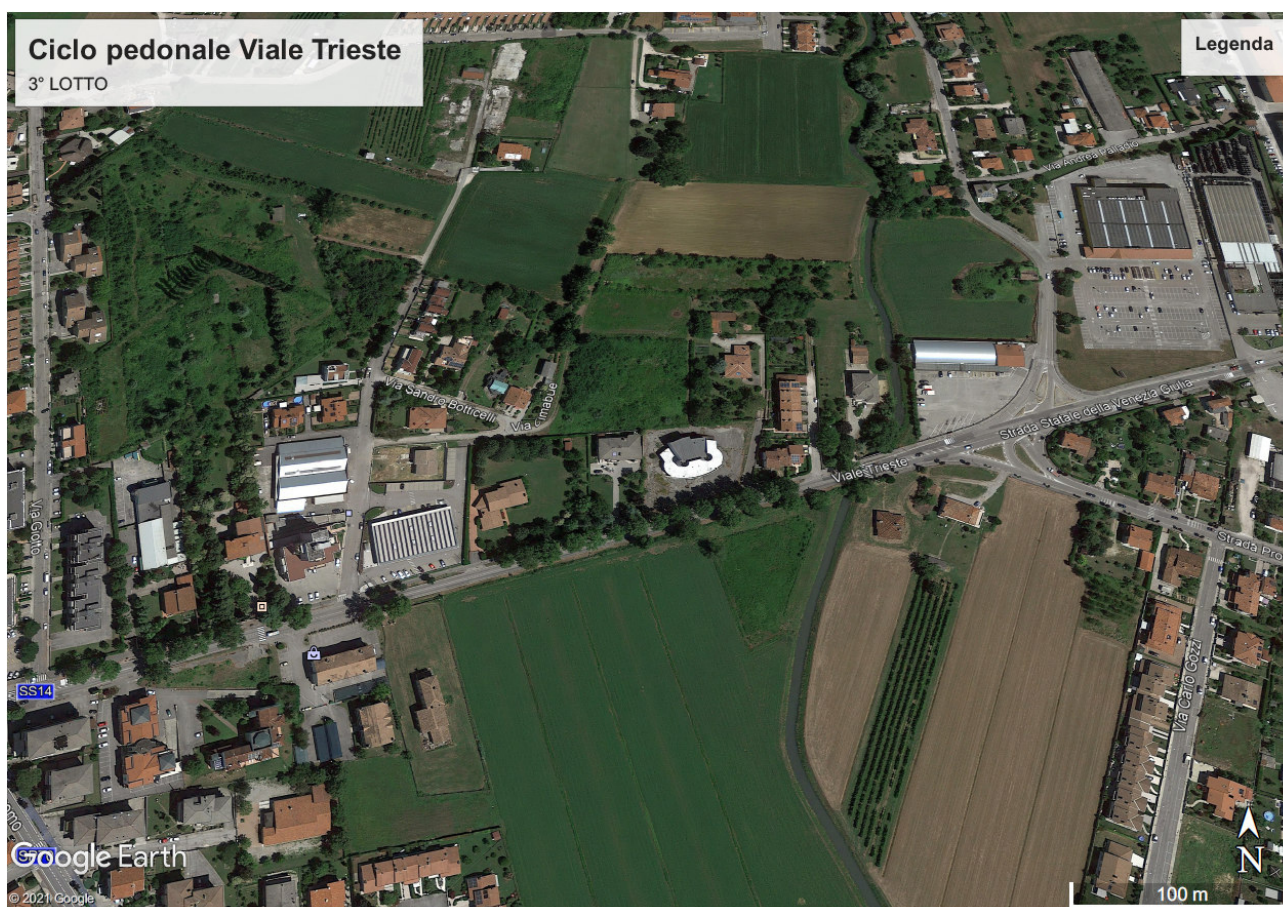
Vista Aerea – tratto Viale Trieste
