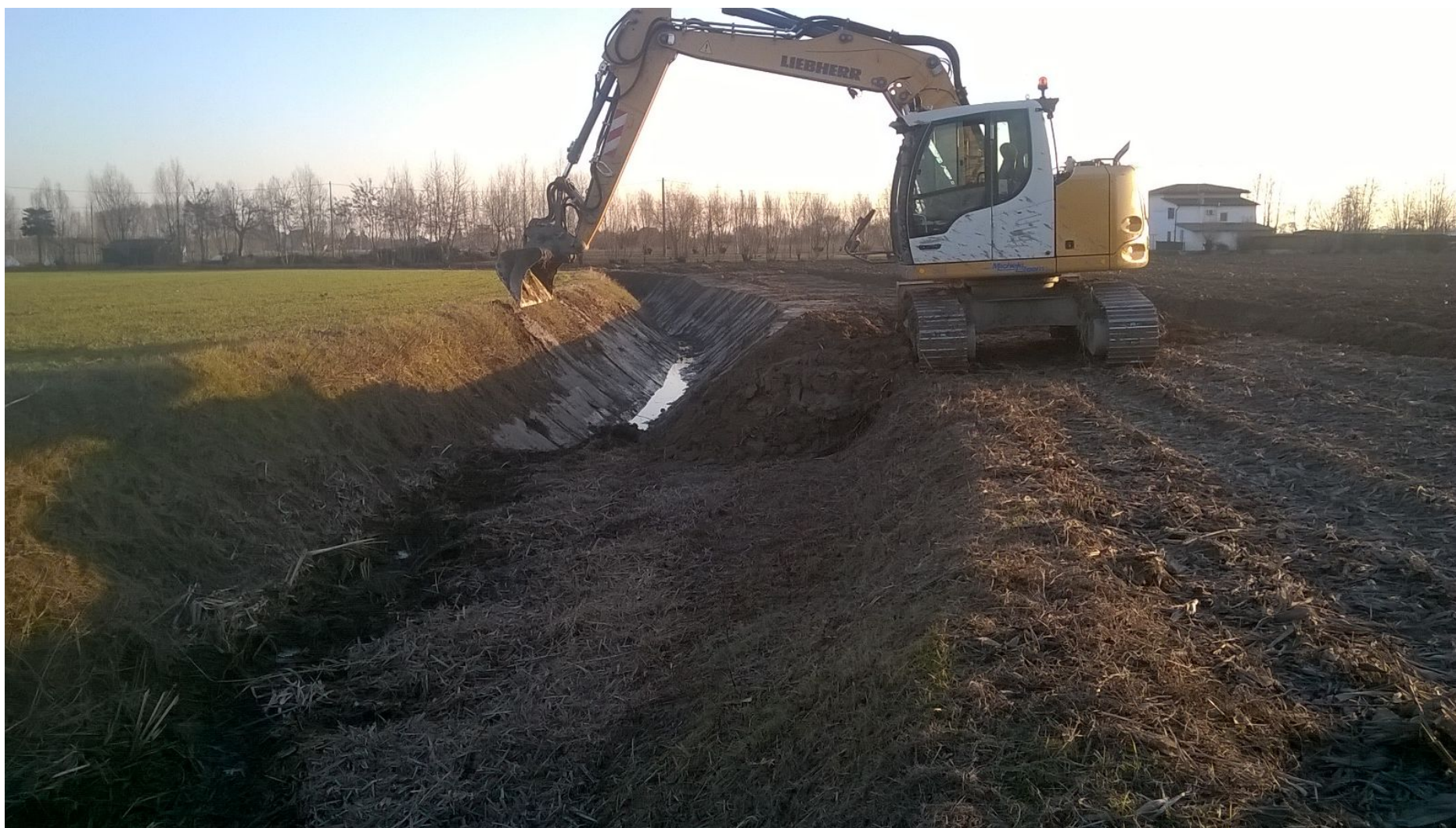
Comune di Fossalta di Portogruaro: Interventi per la Sicurezza idraulica...
