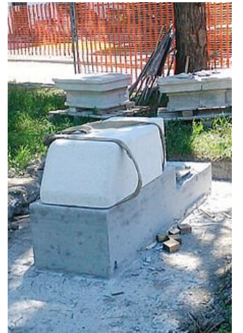
Il cantiere con l'Arco del Fondaco
