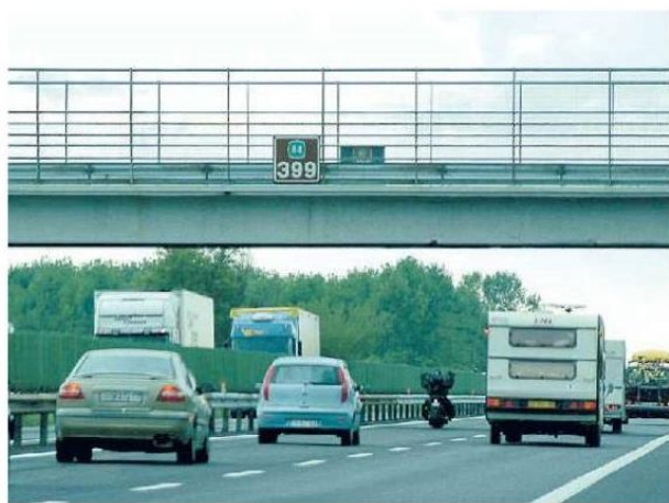
DEMOLIZIONE Chiuso dal 16 settembre il tratto da via Statuti fino al piede della rampa del cavalcavia a sud dell'autostrada
