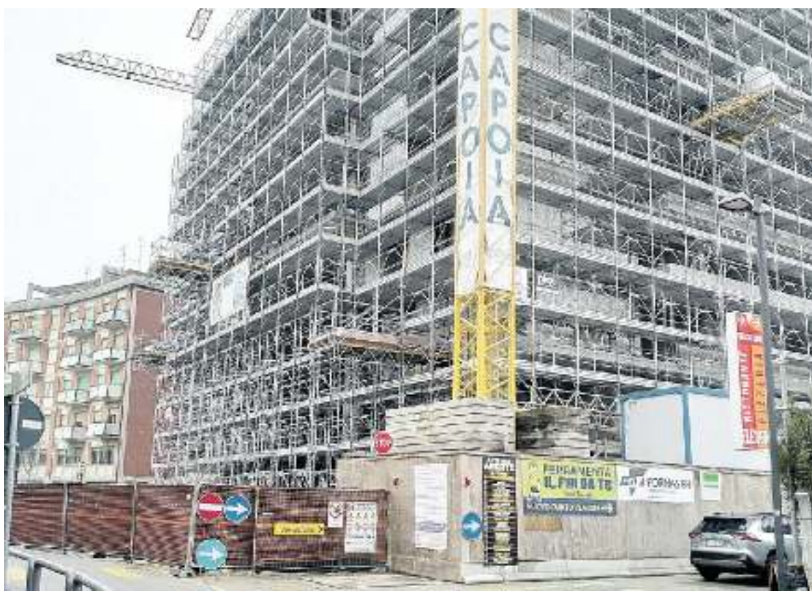
DENUNCE RECENTI Nel cantiere dell'One Hotel Caorle lavoravano in nero stranieri illegali
