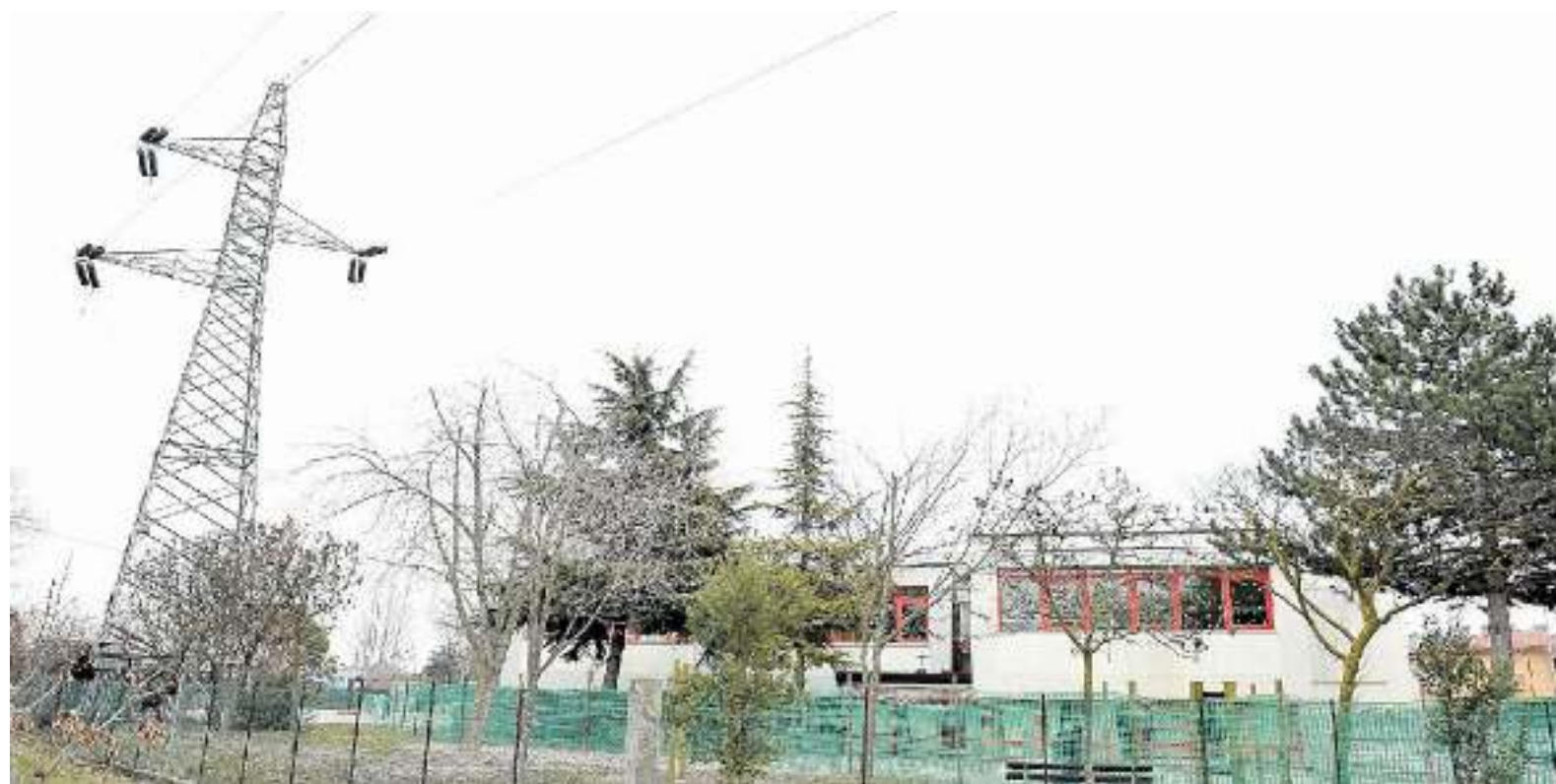
PORTOGRUARO Il traliccio dell'alta tensione nel giardino della scuola di via Magellano. Nel tondo il sindaco Maria Teresa Senatore
