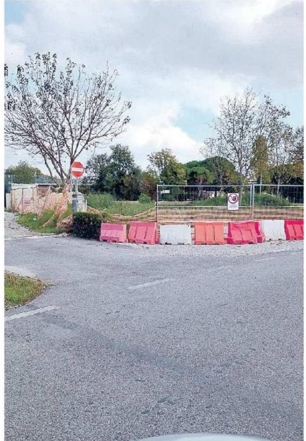
LAVORI IN CORSO Il cantiere fermo da novembre dello scorso anno
