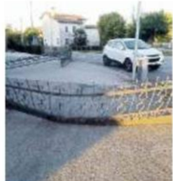
ABBATTUTA La recinzione
