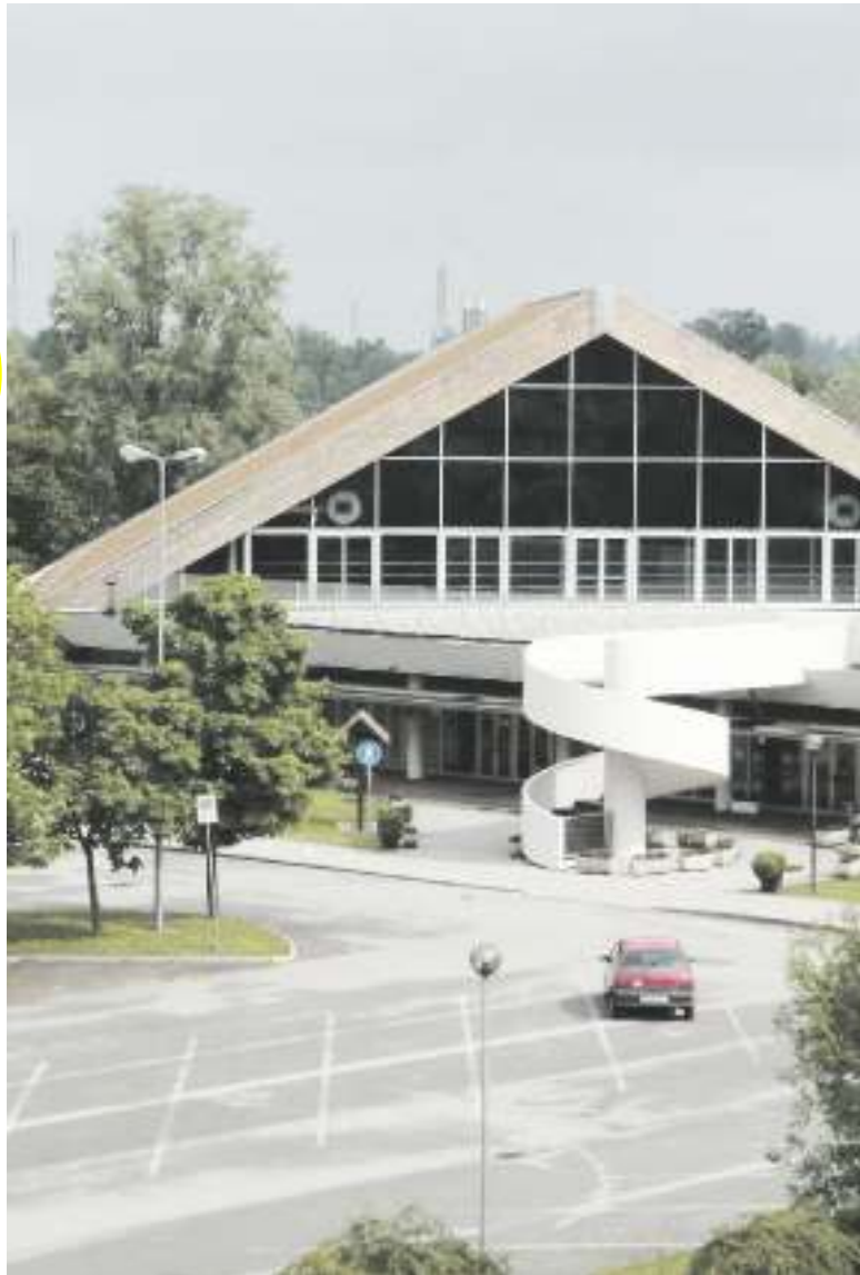
CANTIERE "CONGELATO" Il parcheggio della piscina di Portogruaro dove sabato mattina si terrà la conferenza stampa - raduno.
