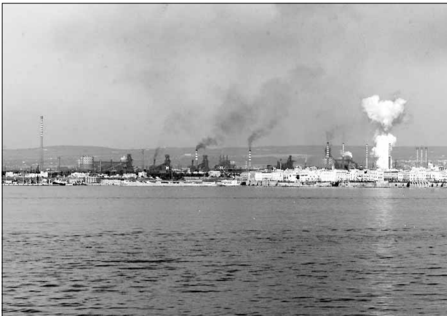
FUMI Una panoramica dello stabilimento Ilva di Taranto il cui sequestro è stato confermato dai giudici
