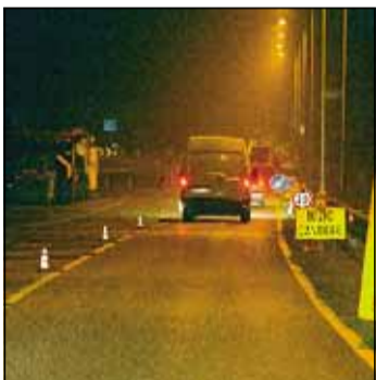
CANTIERE La rotonda in costruzione
