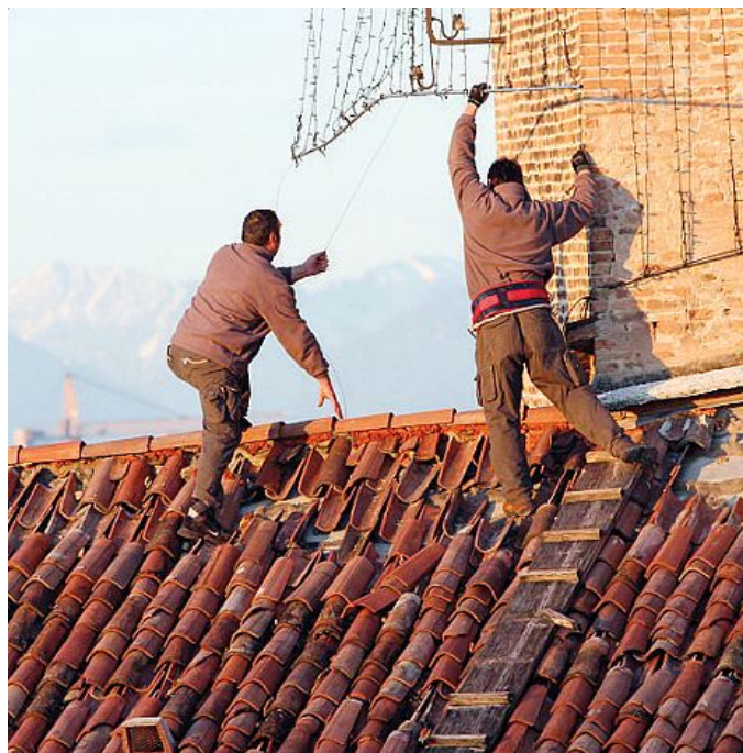
Operai durante un lavoro sul tetto di un edificio storico
