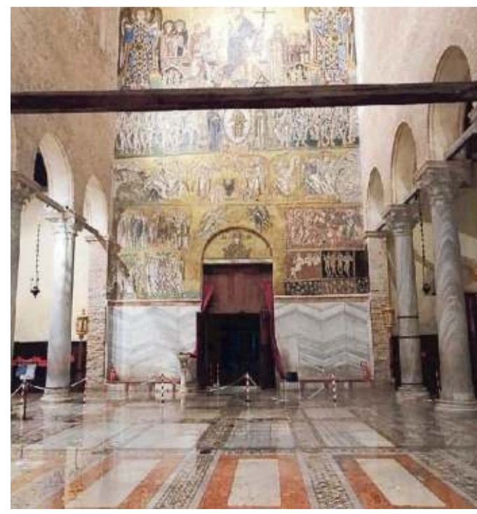
E.P. I pavimenti allagati della basilica di Santa Maria Assunta a Torcello
