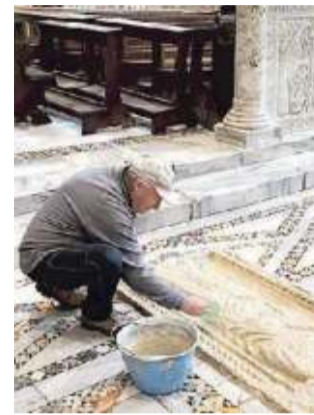
Operai al lavoro alla Basilica
