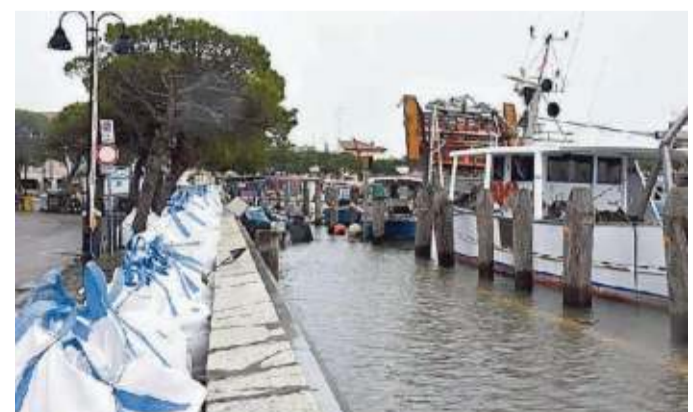
A Caorle sono stati rinforzati i muretti del porto
