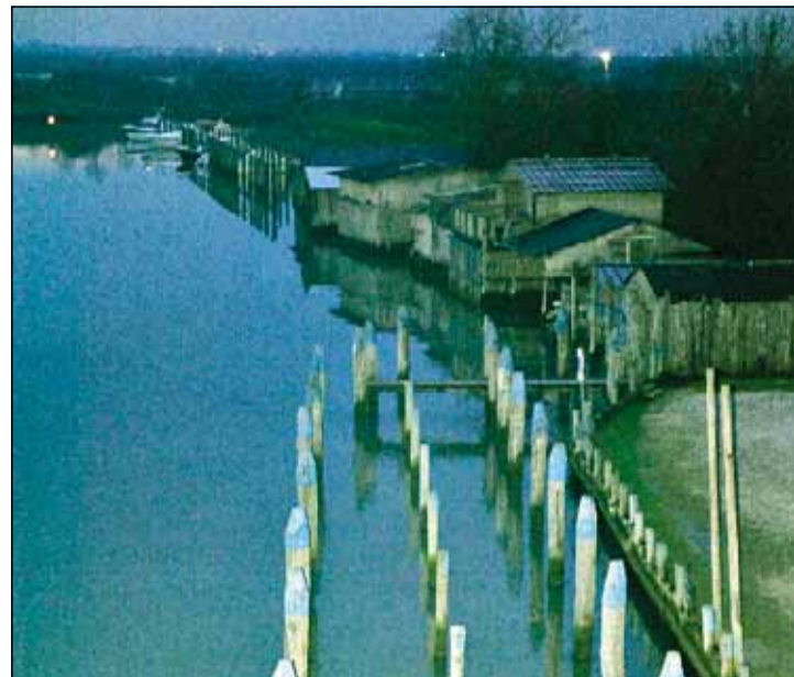
ZONA DI PREGIO L'area è sottoposta a vincolo paesaggistico dal 1972
