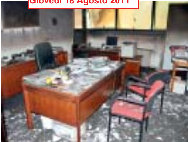
La segreteria dell'istituto professionale come appare dopo il rogo
