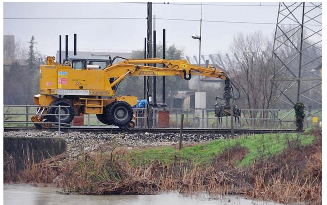
Lavori di ripristino della linea ferroviaria ieri mattina sulla Venezia-Trieste a San Stino
