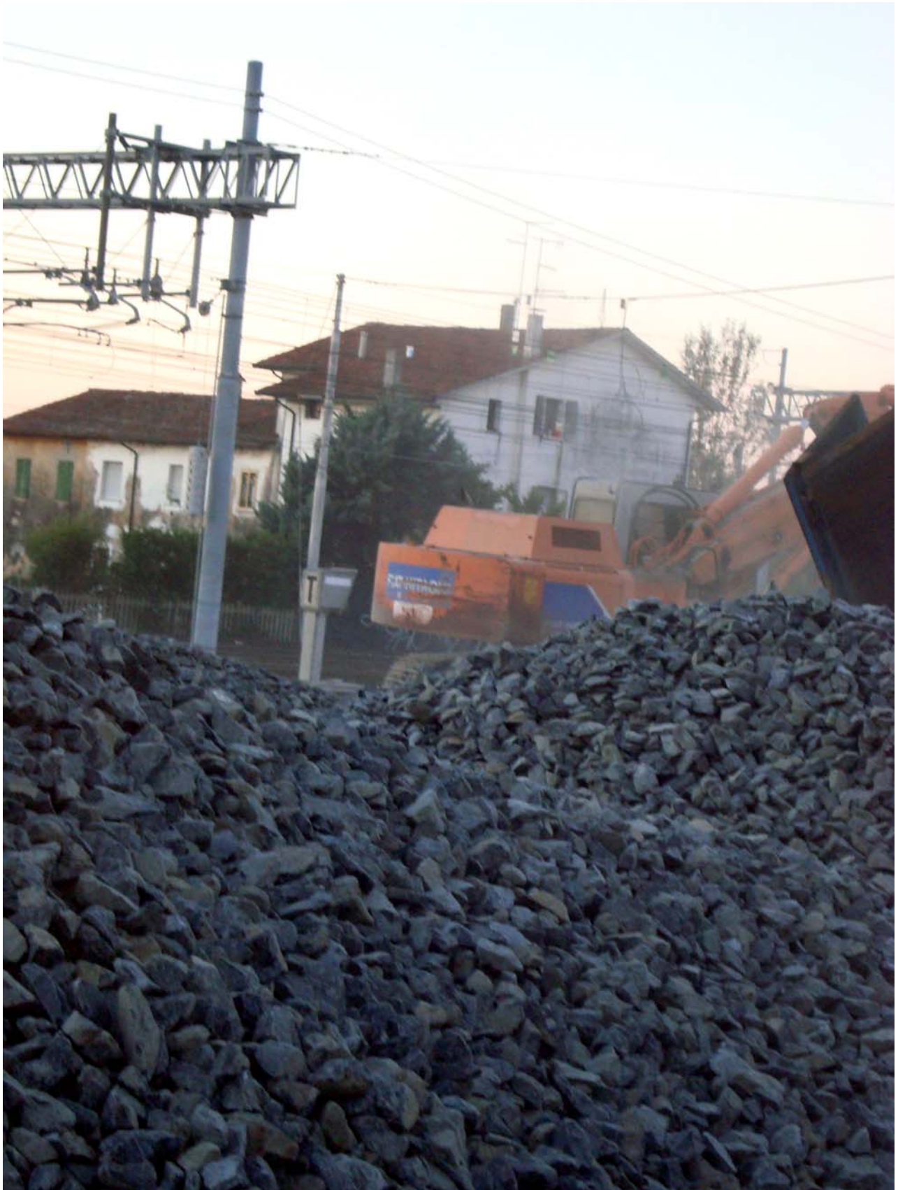
PORTOGRUARO - CANTIERE ADIACENTE VIA NOBILE - OTTOBRE 2014
