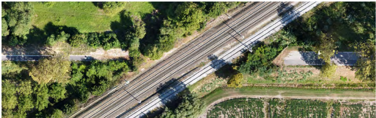
Ortofoto stato di fatto
