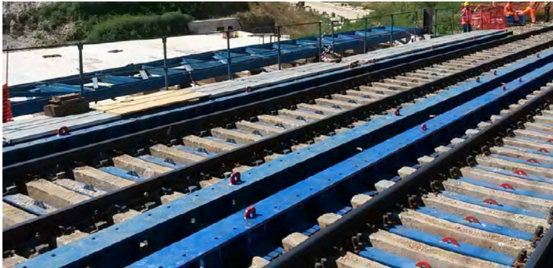
Sistema di sospensione temporanea della sede ferroviaria
