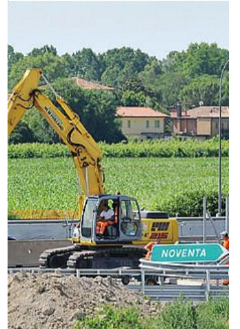
Lavori per la terza corsia in A4
