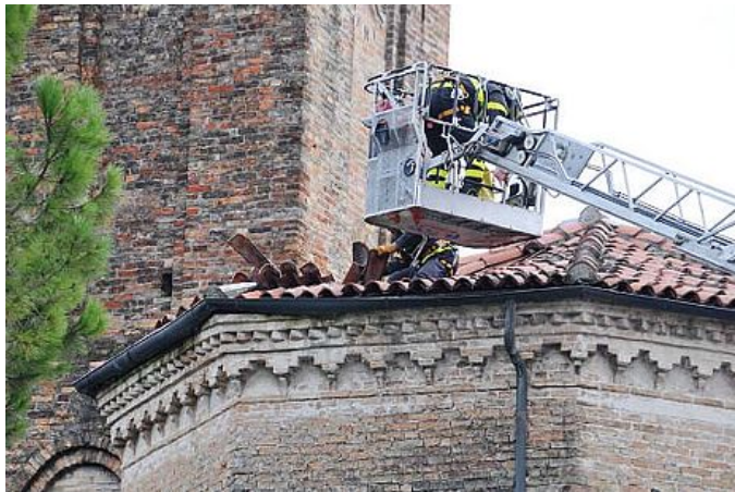
I vigili del fuoco al lavoro per mettere in sicurezza la chiesa
