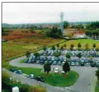
LAVORI AL VIA L'area dell'elisuperficie
