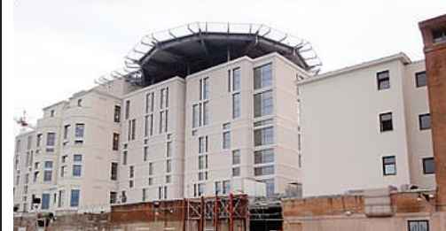
Il padiglione Jona, sul tetto l'elisperficie
