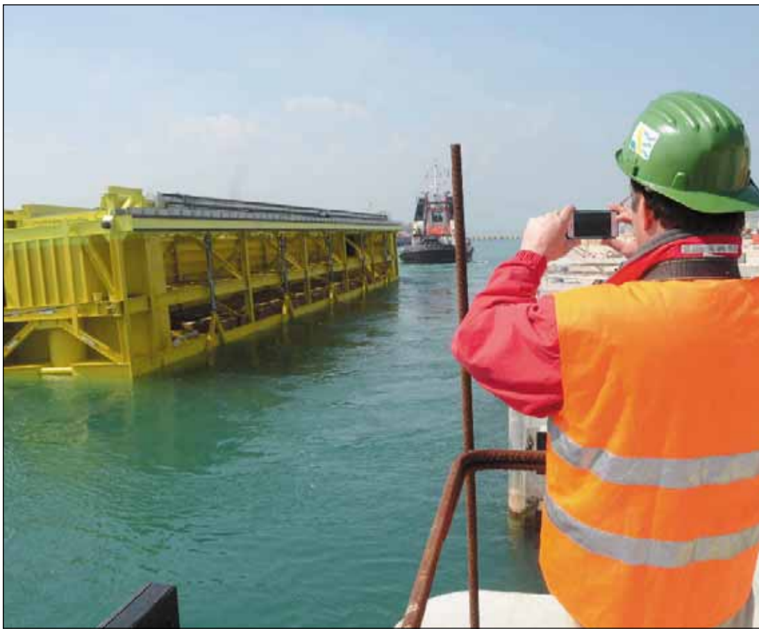
CANTIERE Un elemento del Mose, una "porta di chiusura", installato alla bocca di porto di Malamocco
