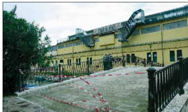
SANT'ELENA Lo stadio al centro dei lavori di manutenzione
