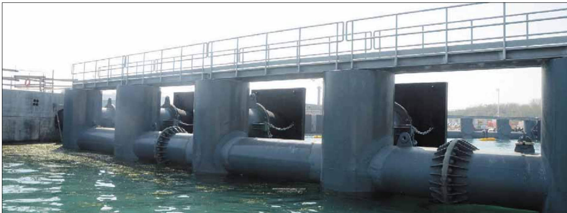
GIGANTESCO In una foto dell'aprile 2014, un particolare dell'immenso cantiere del Mose a Malamocco durante le operazioni di trasporto della paratoia di chiusura fronte mare
